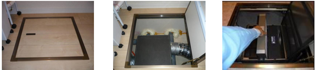
図 4.2.2.15 床下点検口設置型フィルターボックスの事例(提供：積水化学工業)
